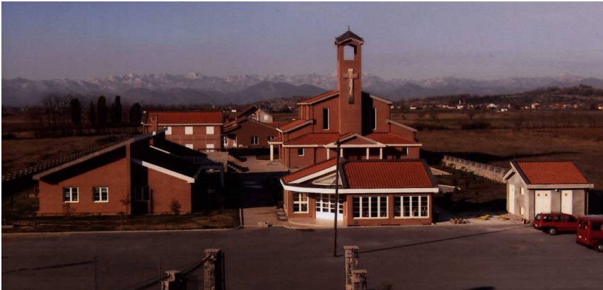
مجمع الأديرة، توزي، الجبل الأسود تجديد أنظمة تزويد الحرارة. تركيب مضخة حرارة هواء/ ماء وتركيب محطة شمسية حرارية.
