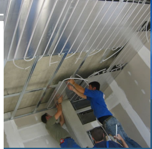
(يمكن دمج غطاء تبريد في قشرة اللوح الخرساني. إن ذلك يضمن عدم إهدار أي مقدارٍ من ارتفاع الغرفة.)
